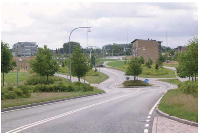
Fordelingsvej i Trekroner. Fordelingsvejen er udlagt som en parkvej i ca 50 meters bredde med plads til store trægrupper, der samtidig afskærmer mod bebyggelserne. Vejen følger det eksisterende bakkede terræn for at undgå terræntilpasninger og begrænse hastigheden.
