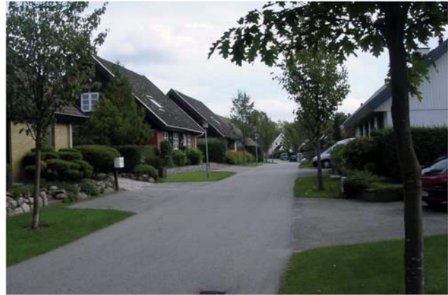
Boligvej i Herfølge. Boligerne er lagt i skel mod vejen for at understrege en gadekarakter, som kendt fra provinsbyer og udstykninger fra 20-erne. Gadebredden er minimeret til ca 4 meter, hvortil er lagt gæsteparkering, der samtidig virker som vigepladser. Bemærk den manglende kantsten, der illustrerer vejplanlægningens opbrud fra strikte normer i 80-erne.
