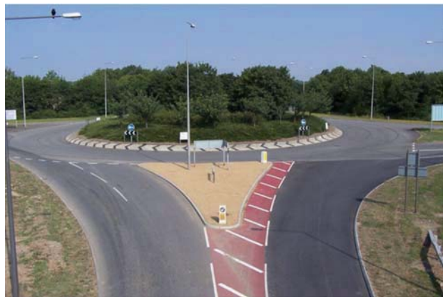
Rundkørsel i Milton Keynes. Alle vejkrøds i byen er udformet som rundkørsler. De 100 meter brede vejudlæg er tilplantet som parkveje.
