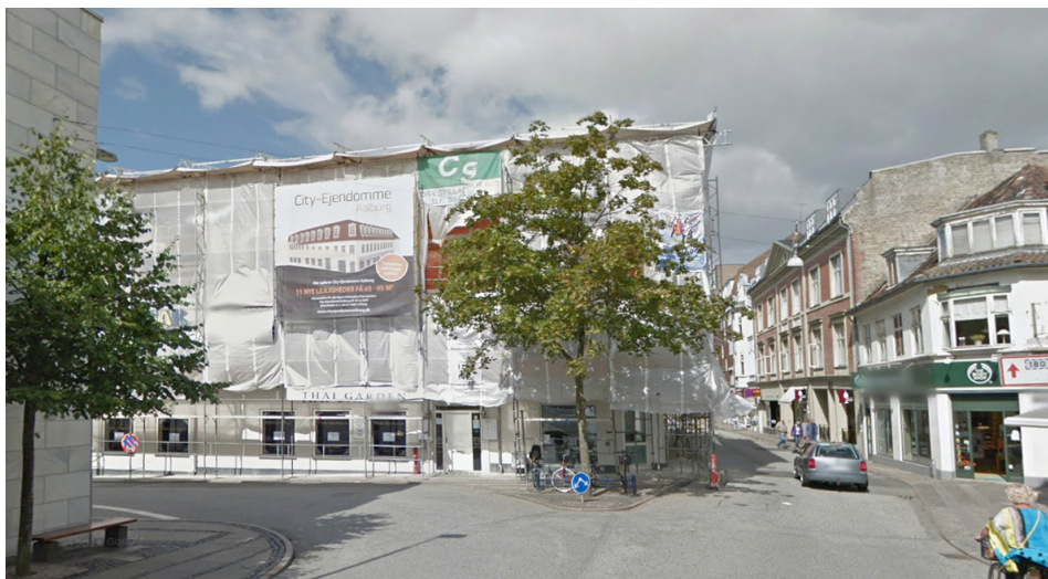
Figur 5 På denne hjørneejendom tæt på Budolfi Plads midt i Aalborg var der tinglyst en ca. 20 år gammel lokalplan, der dels dækkede det meste af bymidten (bl.a. gågaderne) og dels forbød boliger i stueetagen og på 1. sal. Ejeren ønskede at indrette private udlejningslejligheder på 1. sal og 2. sal, men bevare erhverv i stueetagen. Dette var helt i overensstemmelse med kommunens ønske om, at tillade flere boliger i bymidten. Da det blot krævede en ændring af anvendelsesparagraffen i lokalplanen vurderede kommunen, at det var en unødigt tidskrævende proces, at udarbejde en ny lokalplan. I stedet benyttede kommunen den nye mulighed i planloven til via en forholdsvis hurtig proces, at aflyse den gamle lokalplan. Det uheldige ved denne manøvre var, at vi nu ikke har en lokalplan for bymidten, der forbyder boliger i stueetagen i bl.a. gågaderne. Vi er nødsaget til via kommuneplanens rammer evt. at skulle nedlægge et § 14 forbud. En aflysning af dele af lokalplanen havde været mere enkel og realistisk. Foto: Aalborg Kommune
